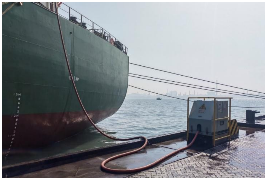
图6 靠港船舶使用岸电
